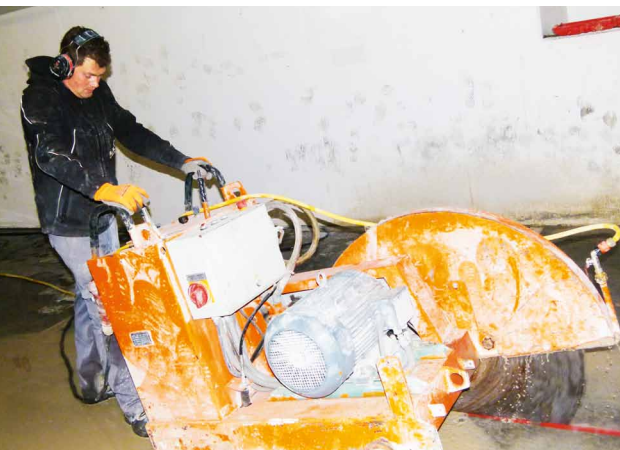
Ronny Miersch hat sich mit seiner Roggdenener Firma auf Betonbohrungen spezialisiert.
